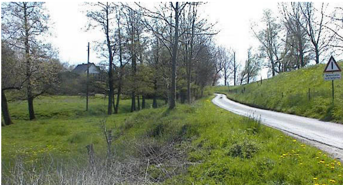
Im Schleusenfeld / sluice-field / Oste-dike
